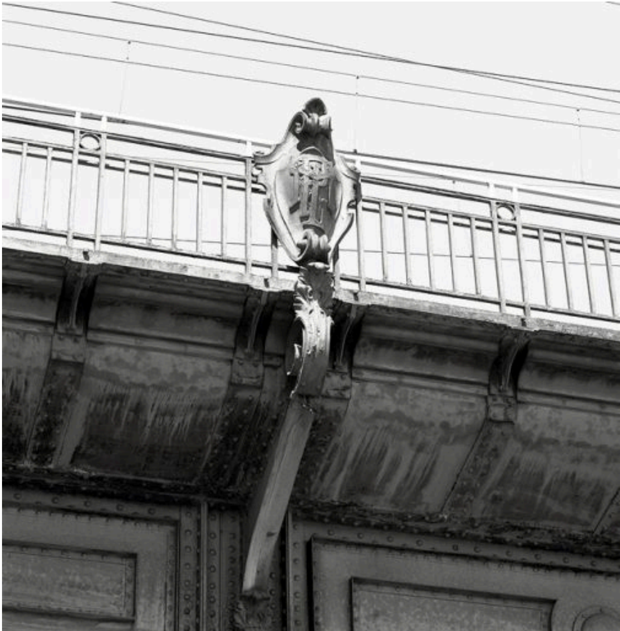
Travée de rive, quai Perrache : détail du cartouche du garde-corps, marqué PLM
