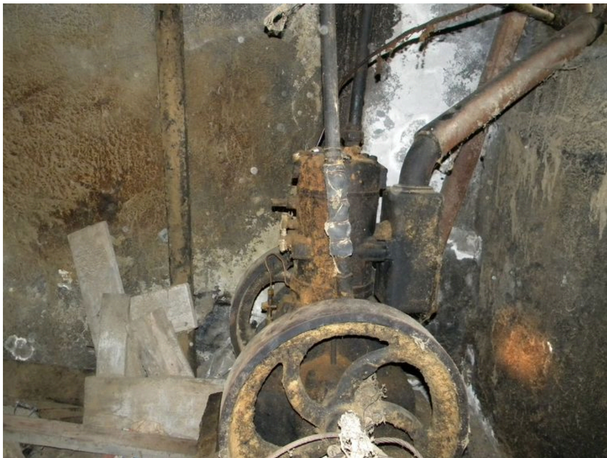
Vue de l'ancien moteur thermique.
