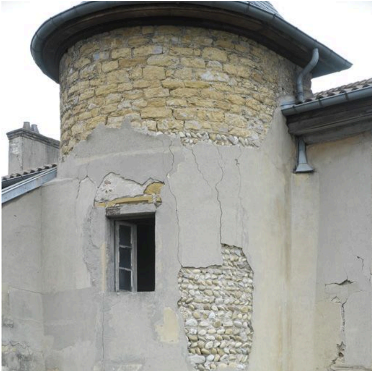
Façade est. Tour est. Détail des matériaux
