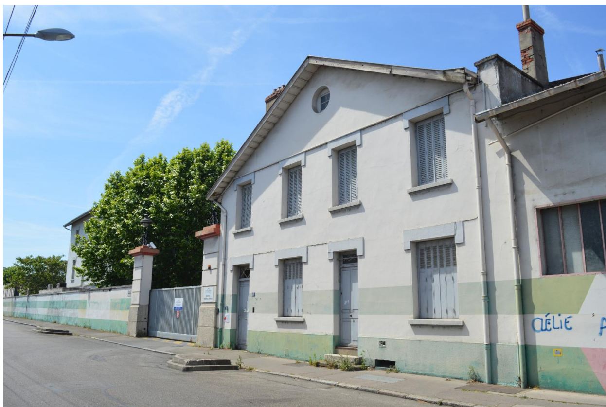
Saint-Gobain - Savoie Réfractaires - Bâtiment administratif - vue depuis la rue de l'Industrie
