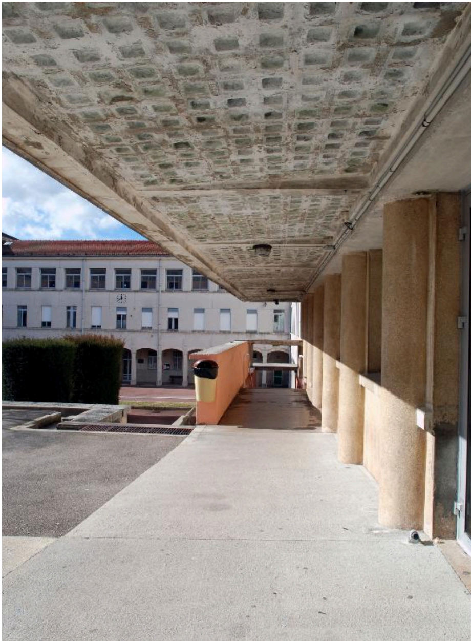
Montée d'escalier reliant les deux cours, vue depuis le palier supérieur, et auvent en briques de verre et ciment
