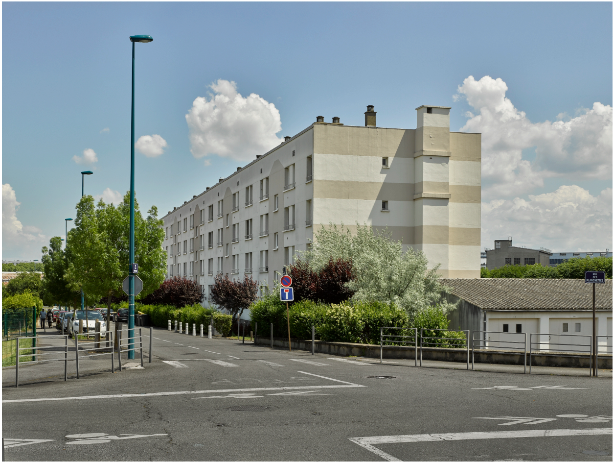
Ensemble collectif n°2, immeuble à l'angle des rues de la Fontcimagne et des Planchettes.
