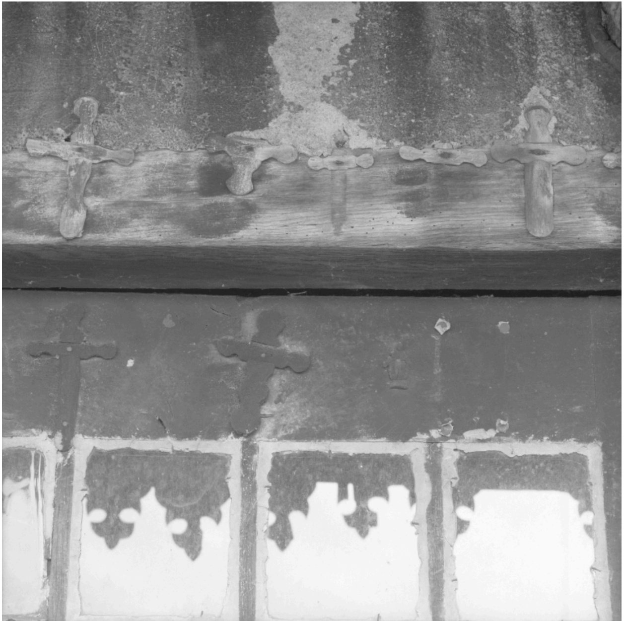
Détail de l'encadrement de la porte du rez-de-chaussée, partie centrale : "croisettes".
