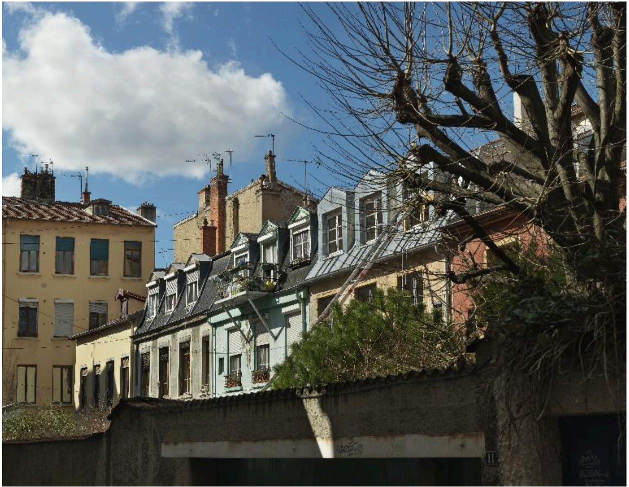
Détail des toitures des maisons du passage Lamure
