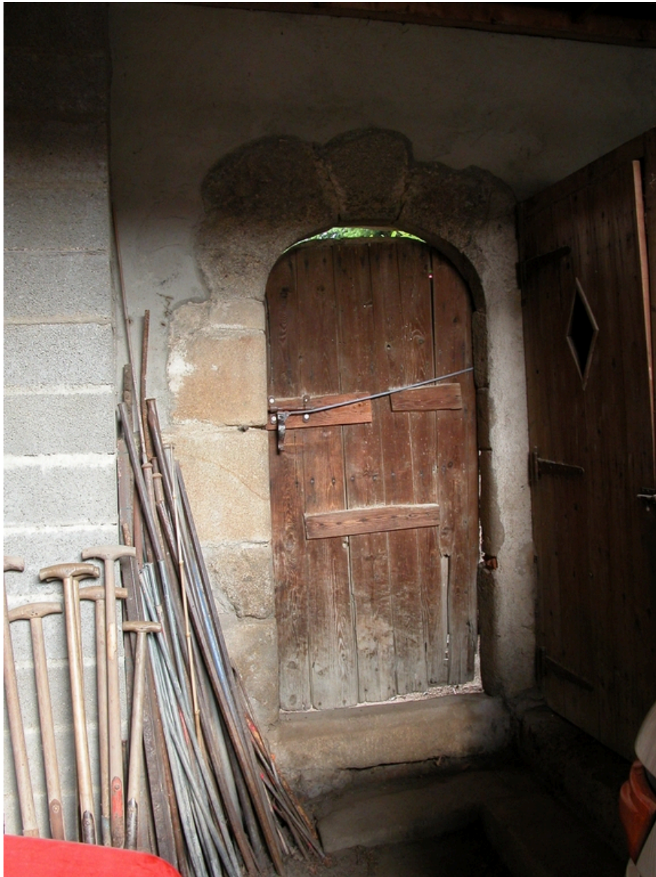
Faubourg du Chauffour, route de la Boën. Demeure, puis ferme, puis maison (1999 AD 40). Détail d'une porte.
