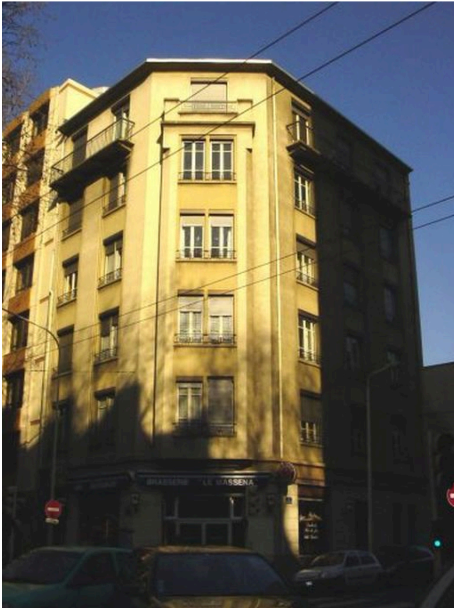
Vue générale de l'élévation sur rue
