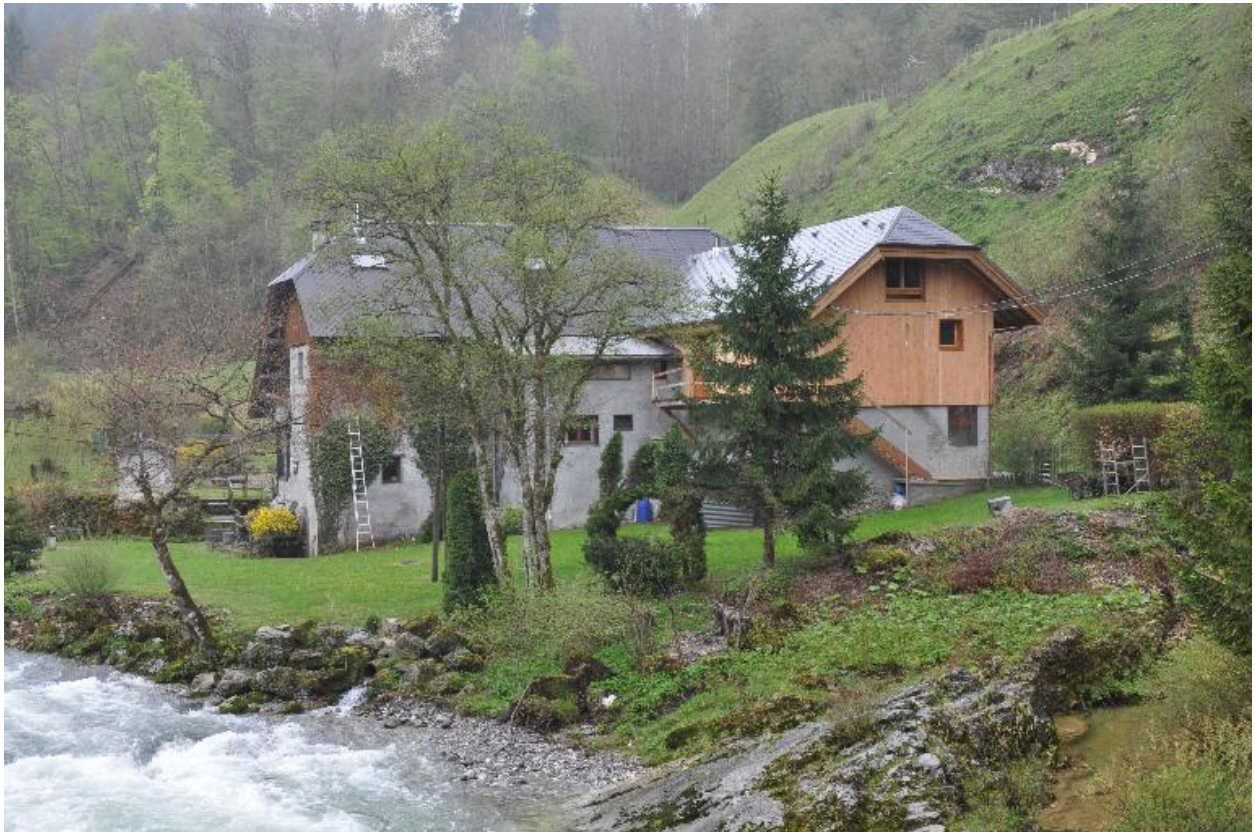
Vue du site coté nord.
