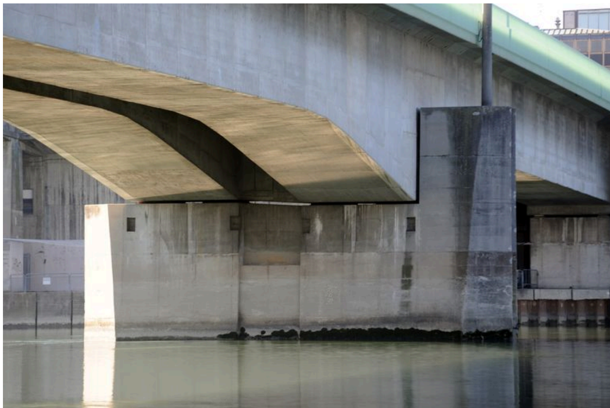
Pile, de côté, face amont, vue générale (depuis la rive gauche)
