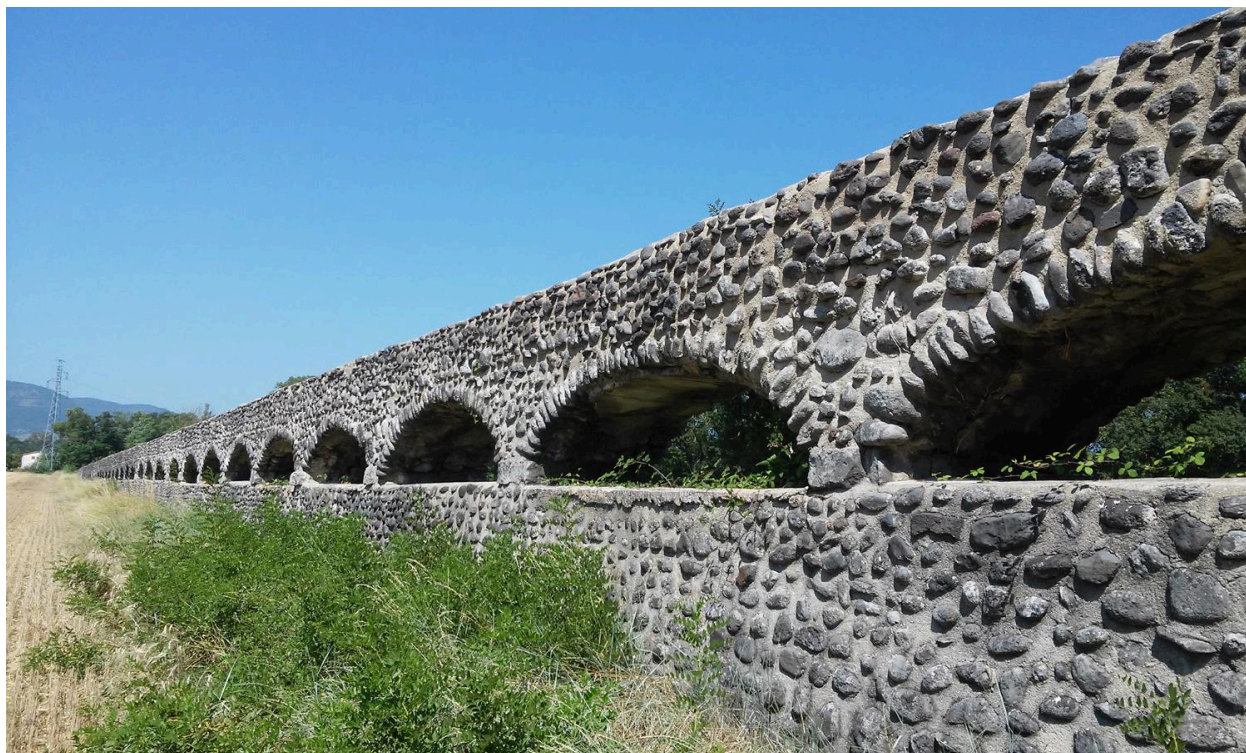
Aqueduc vue ouest
