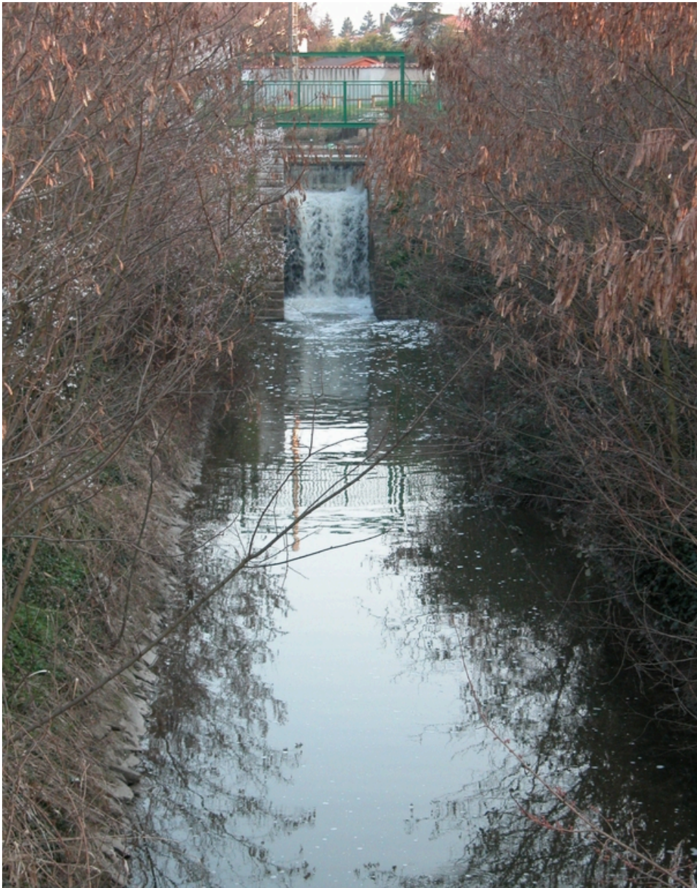
Vue de la chute d'eau du canal (vers l'amont).
