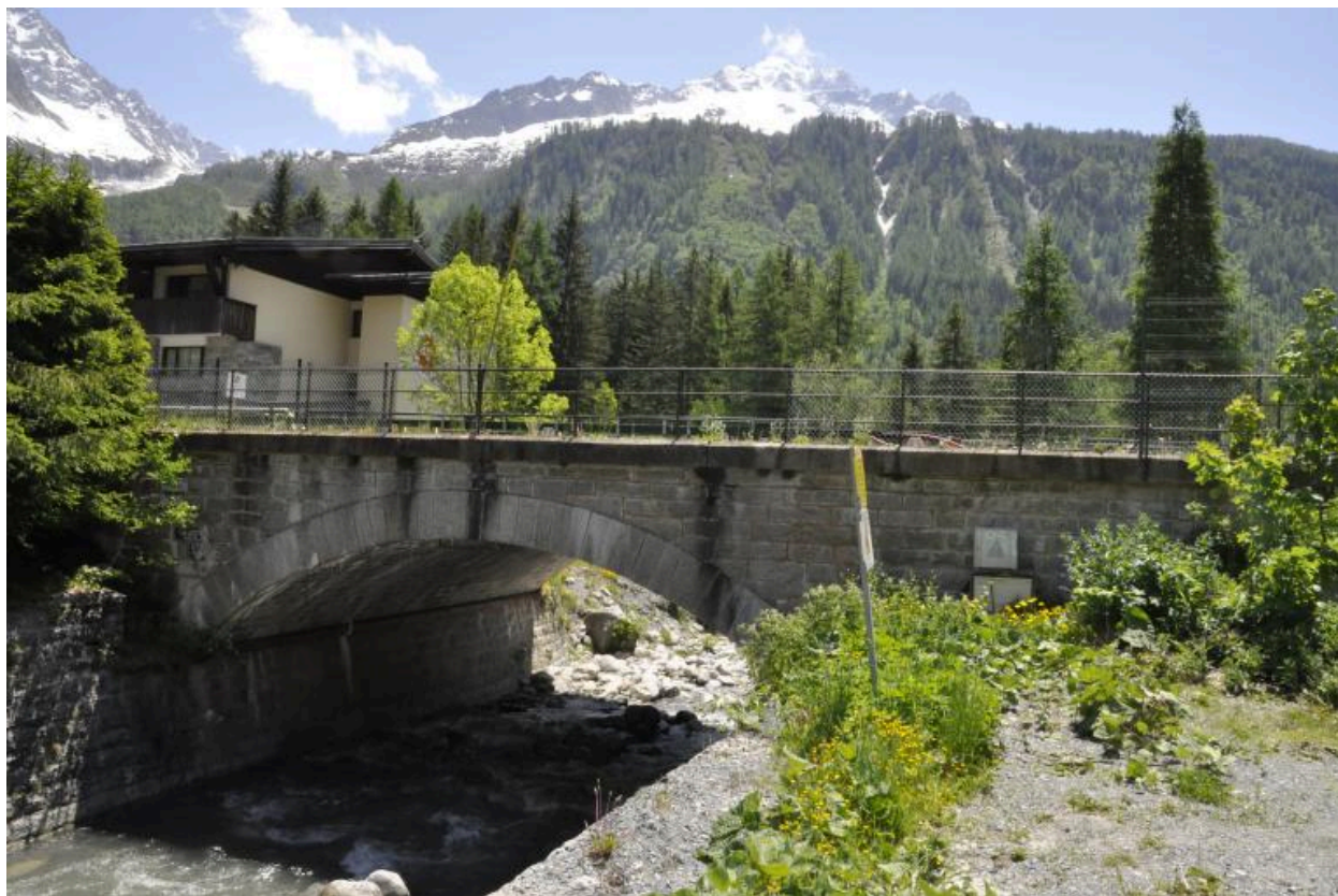
Vue de la face amont du pont
