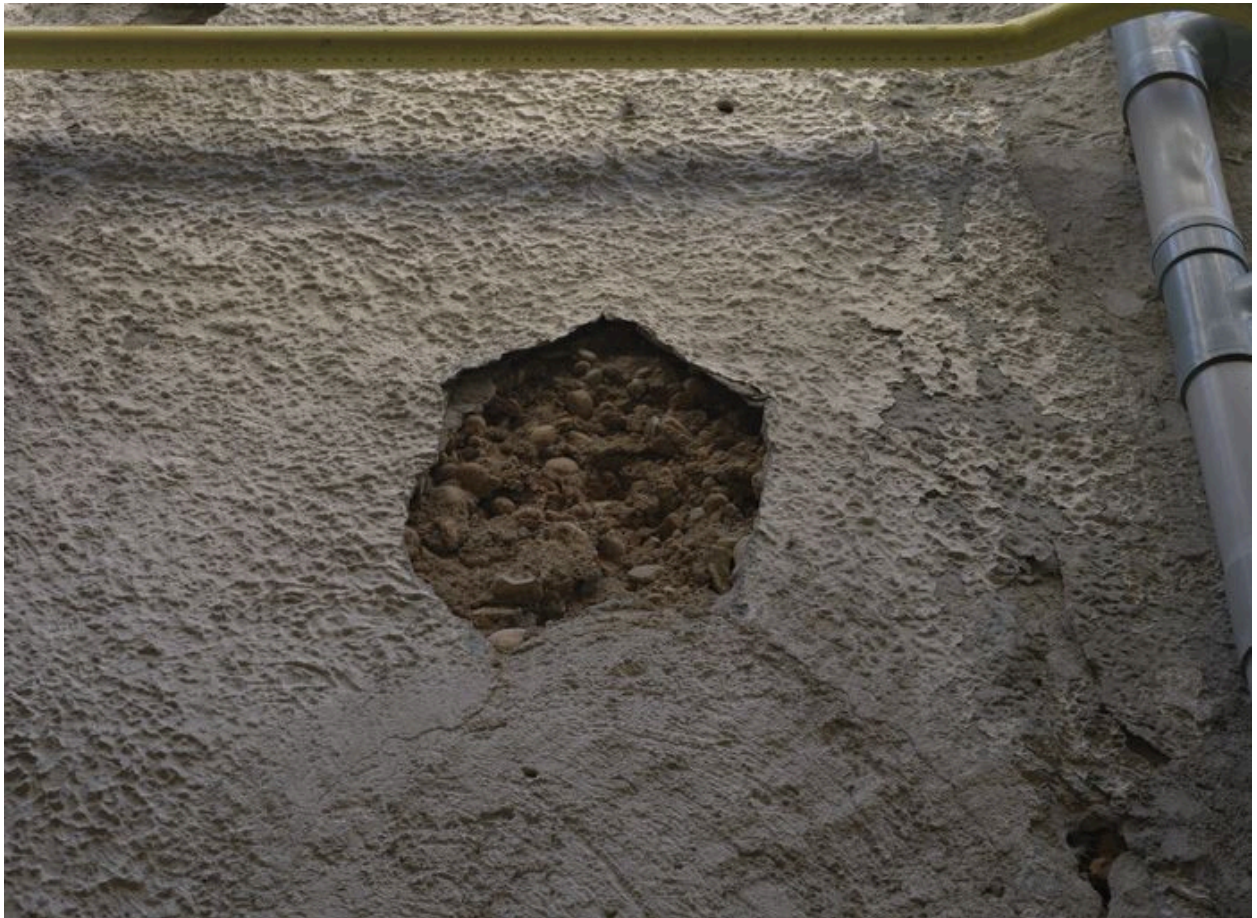
Vue du mur de pisé sous le crépi
