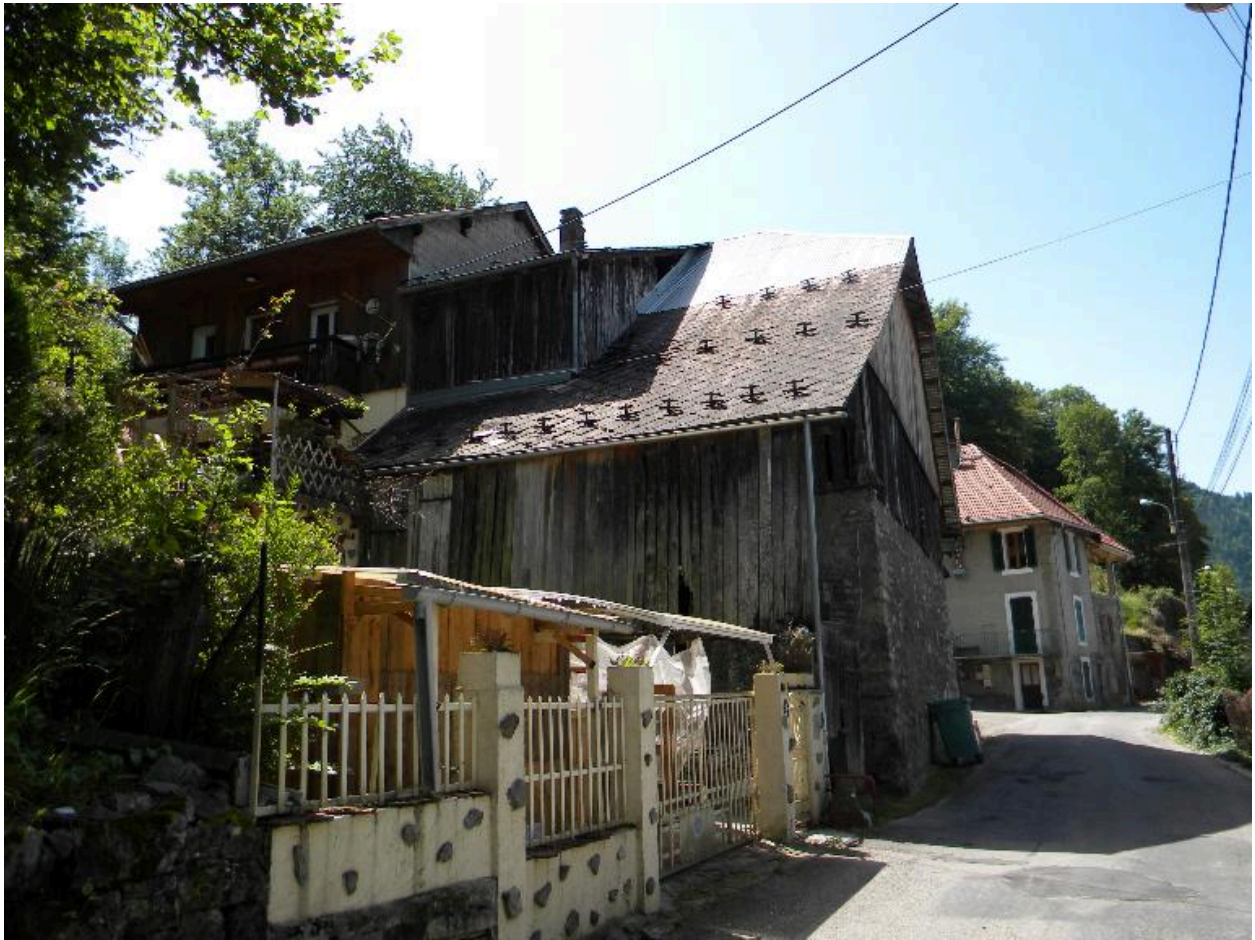
Vue de la façade arrière.
