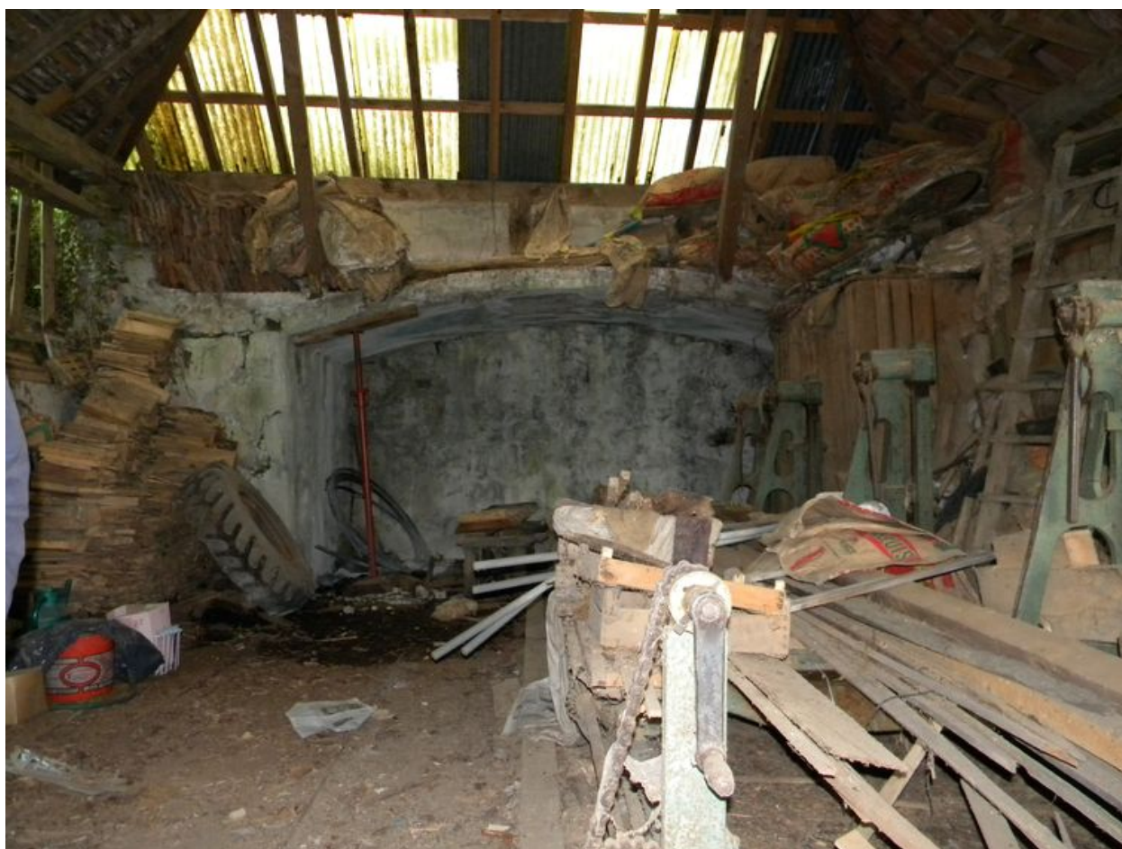
Vue de la partie maçonnée plus ancienne au fond de la scierie.
