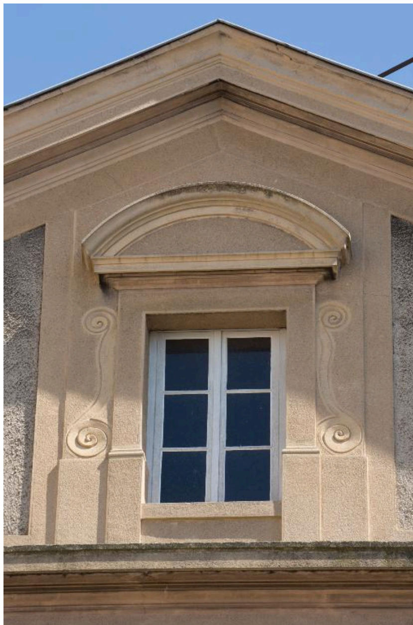
Bâtiment G, façade orientale. Fenêtre du fronton
