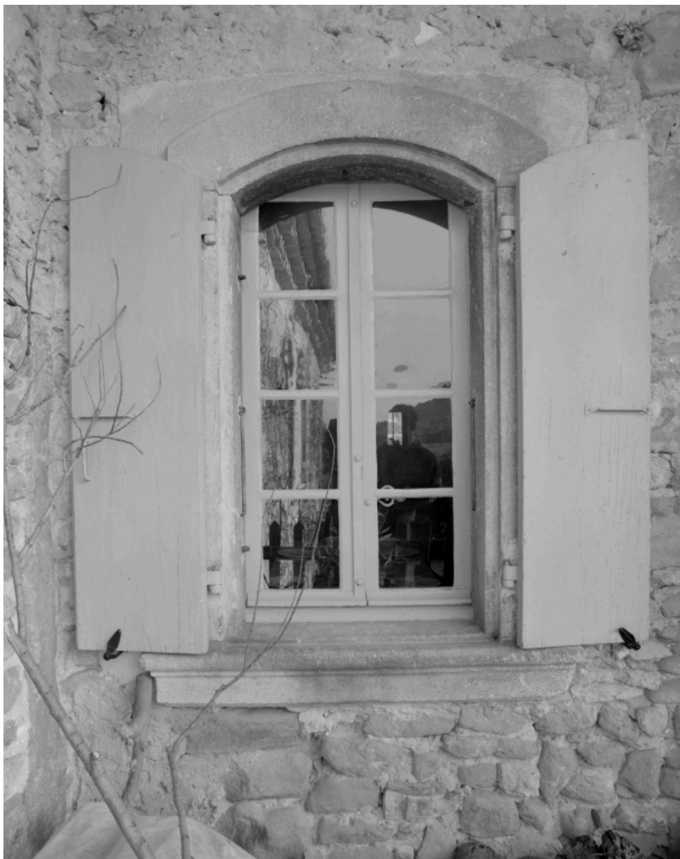
Détail d'une fenêtre du logis.
