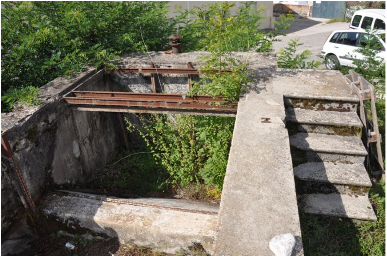
Arrivée de la prise d'eau sur le site de l'usine
