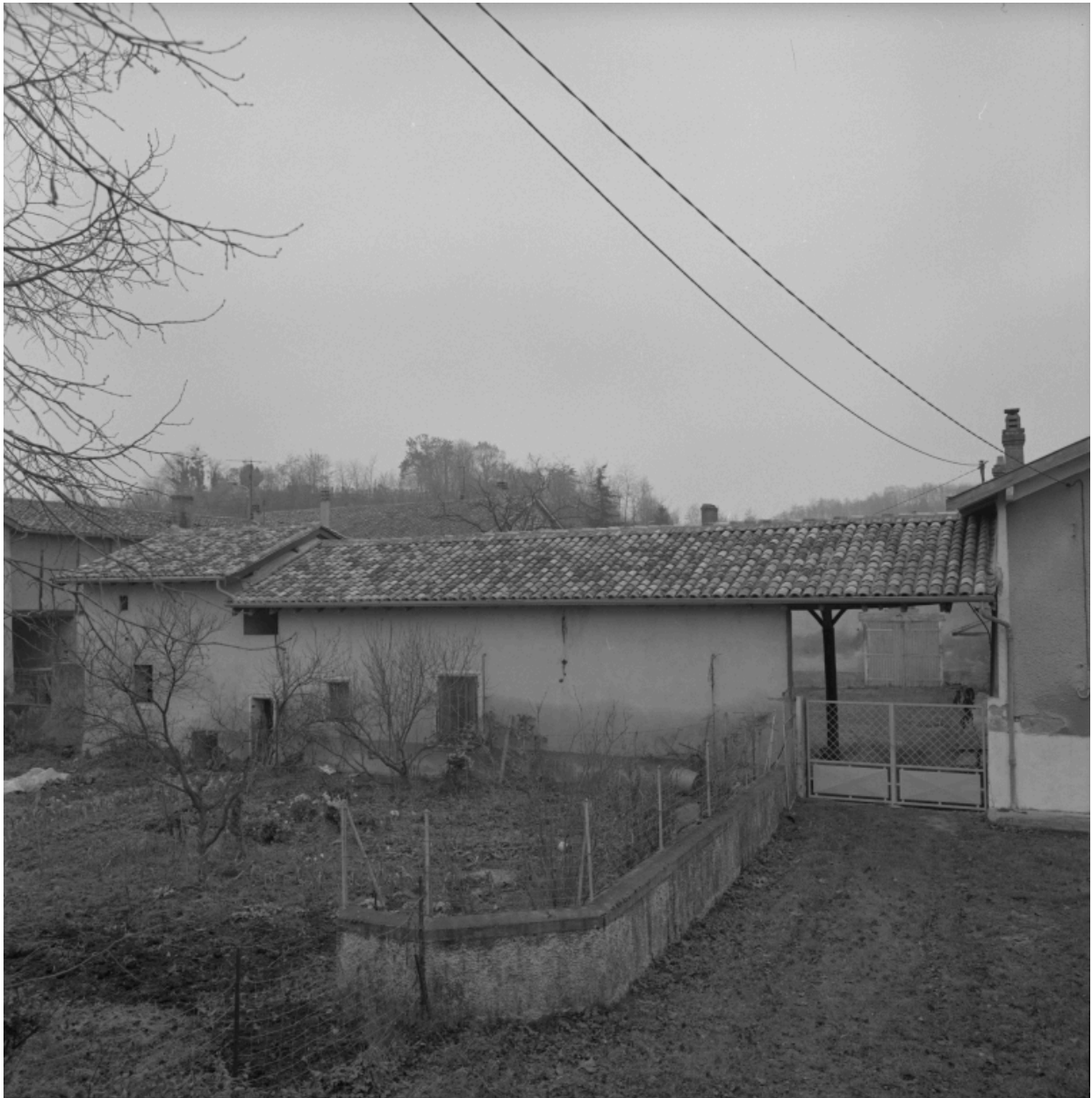
Corps de porche, élévation antérieure.
