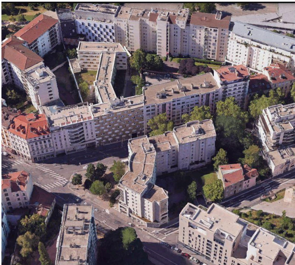
Foyer Sonacotra, vue d'ensemble de la parcelle (vue Google)
