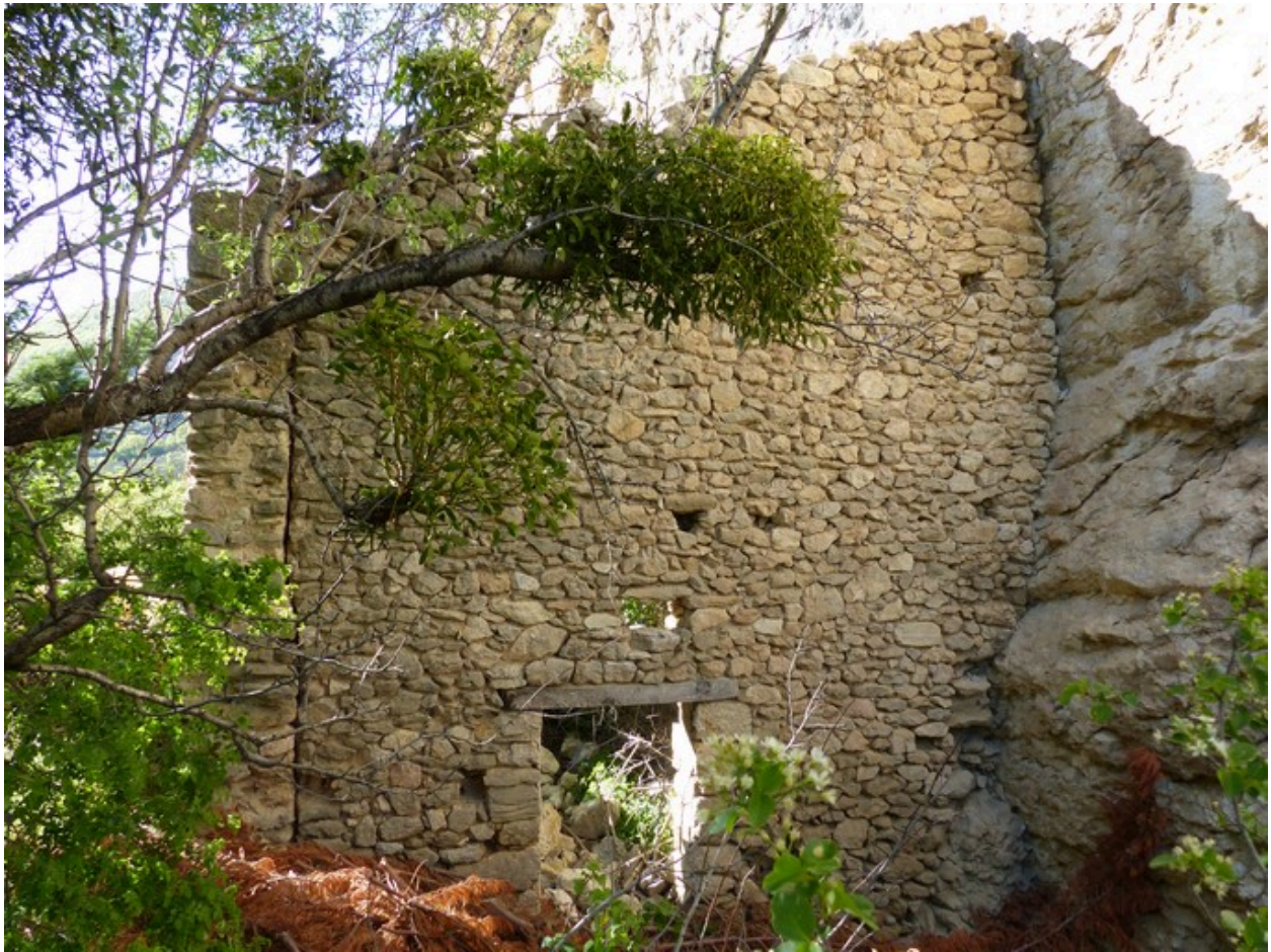
Entrepôt agricole au quartier de la Cour, adossé au rocher.
