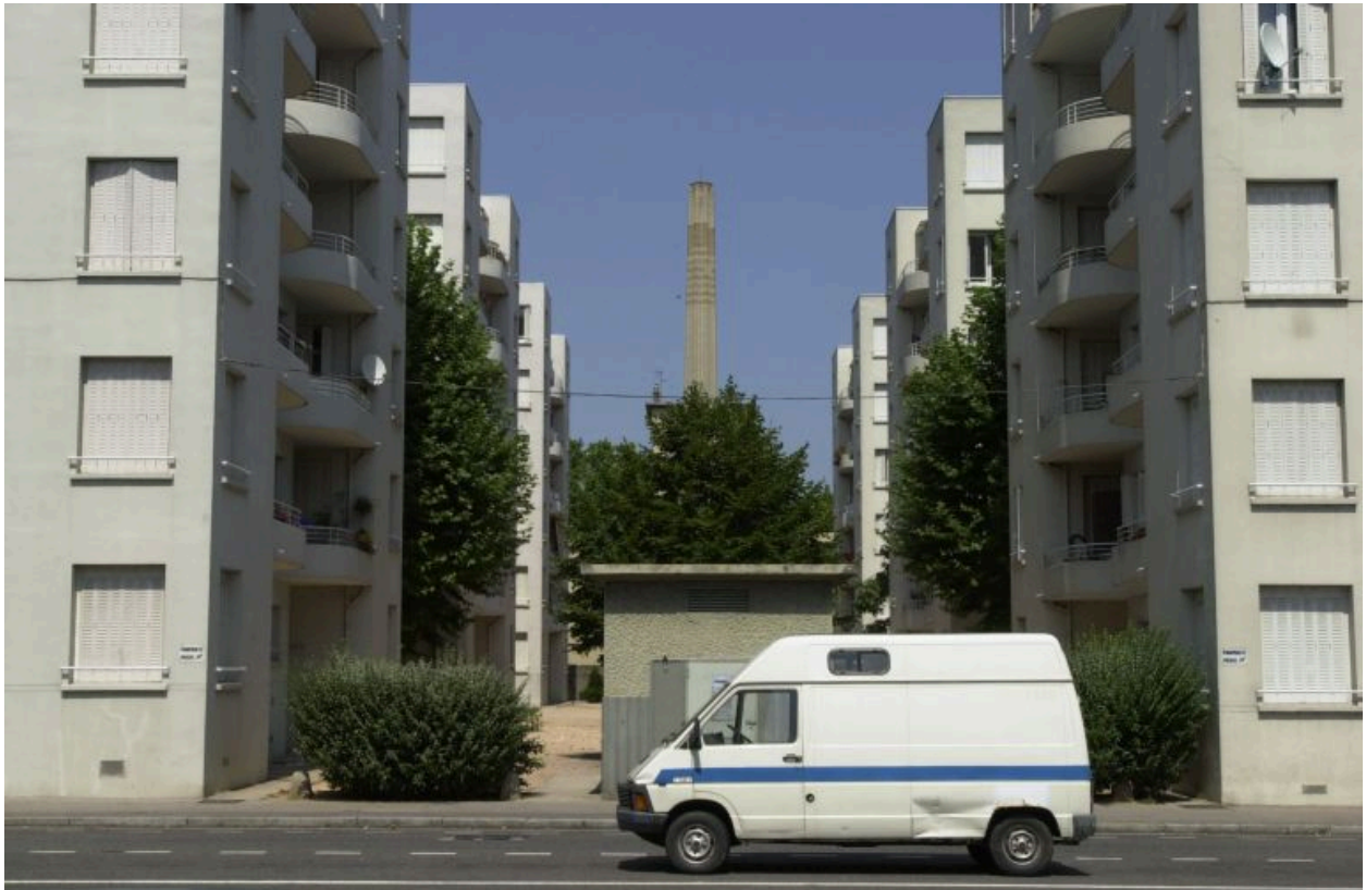
L'allée centrale depuis le sud
