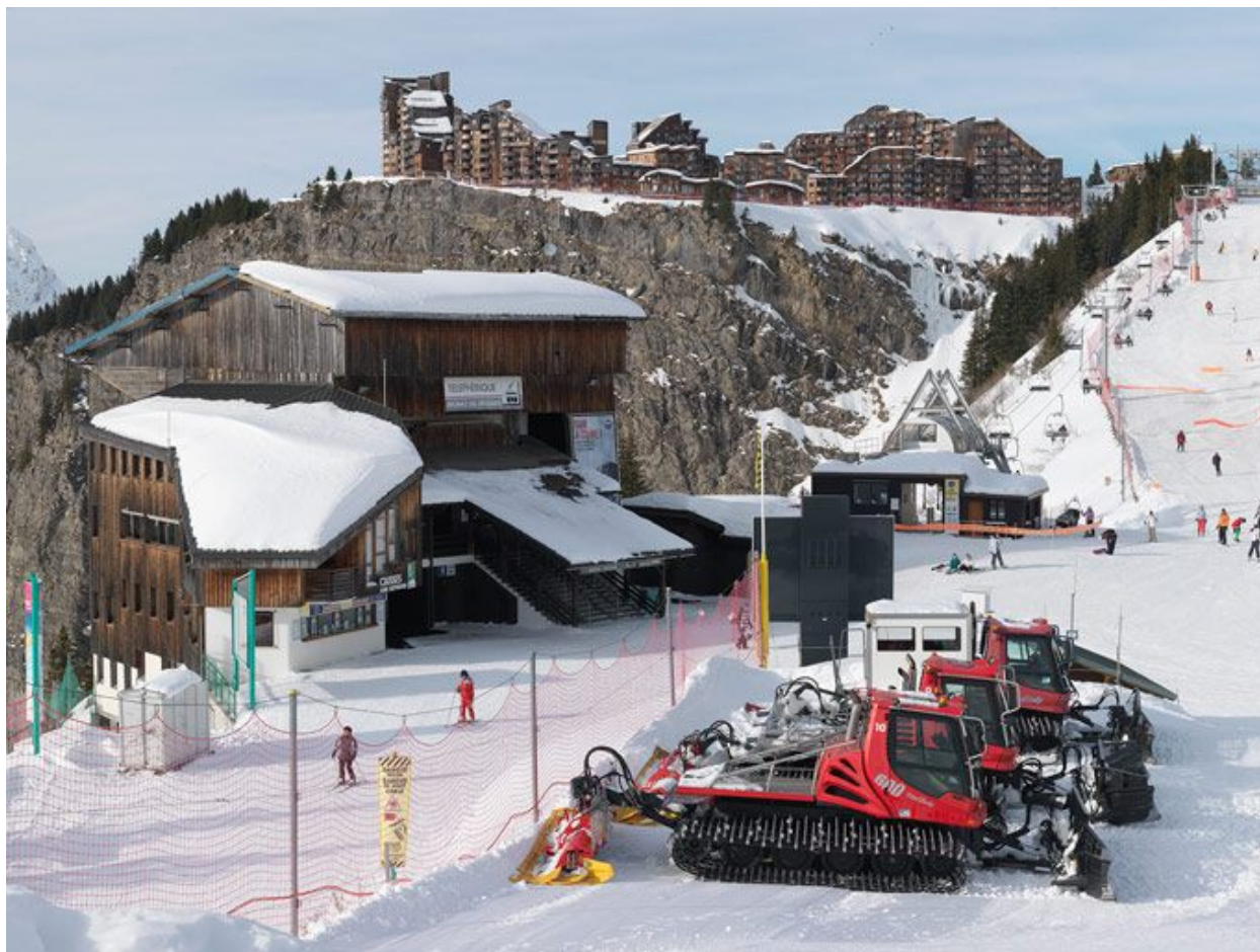
Vue depuis le sud-est
