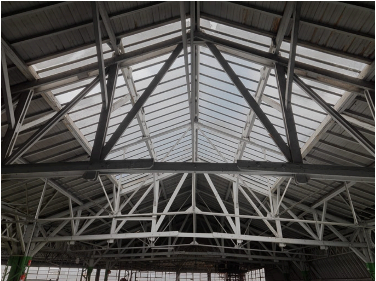
Vue de la charpente mixte bois et fer
