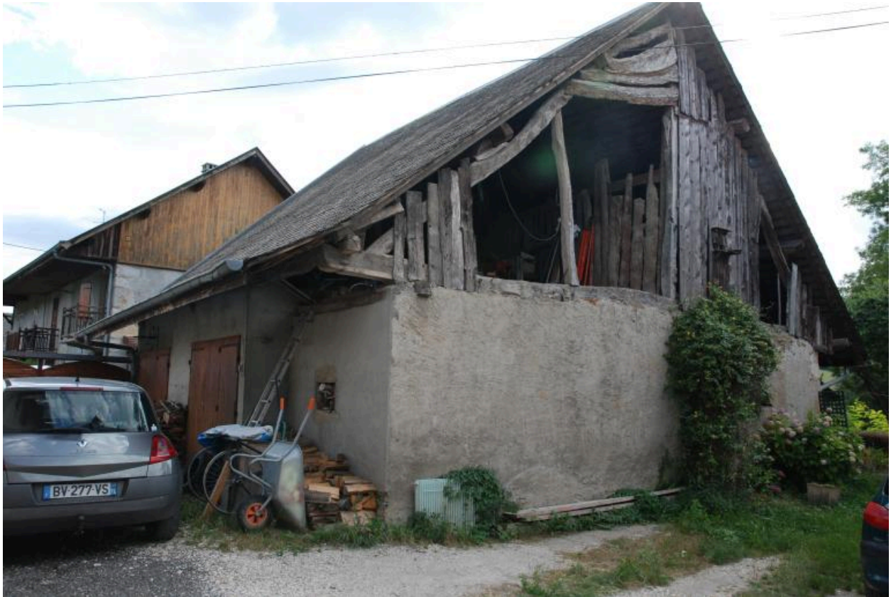
Ferme (2017 C4 352), non repérée. Habitation, grange et étable, vue arrière.
