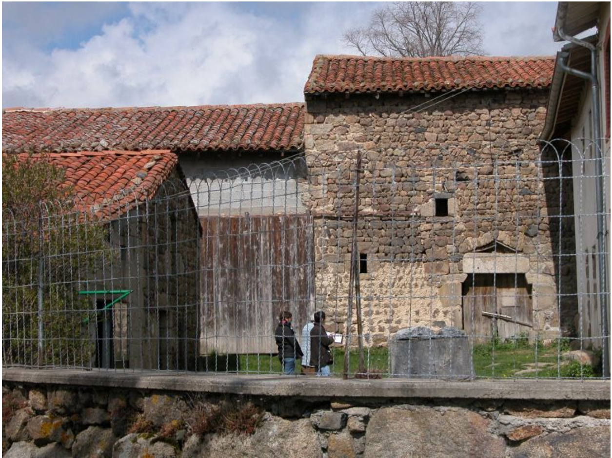
Vue d'ensemble de la grange-étale de la parcelle 632, depuis la ferme de la parcelle 82.
