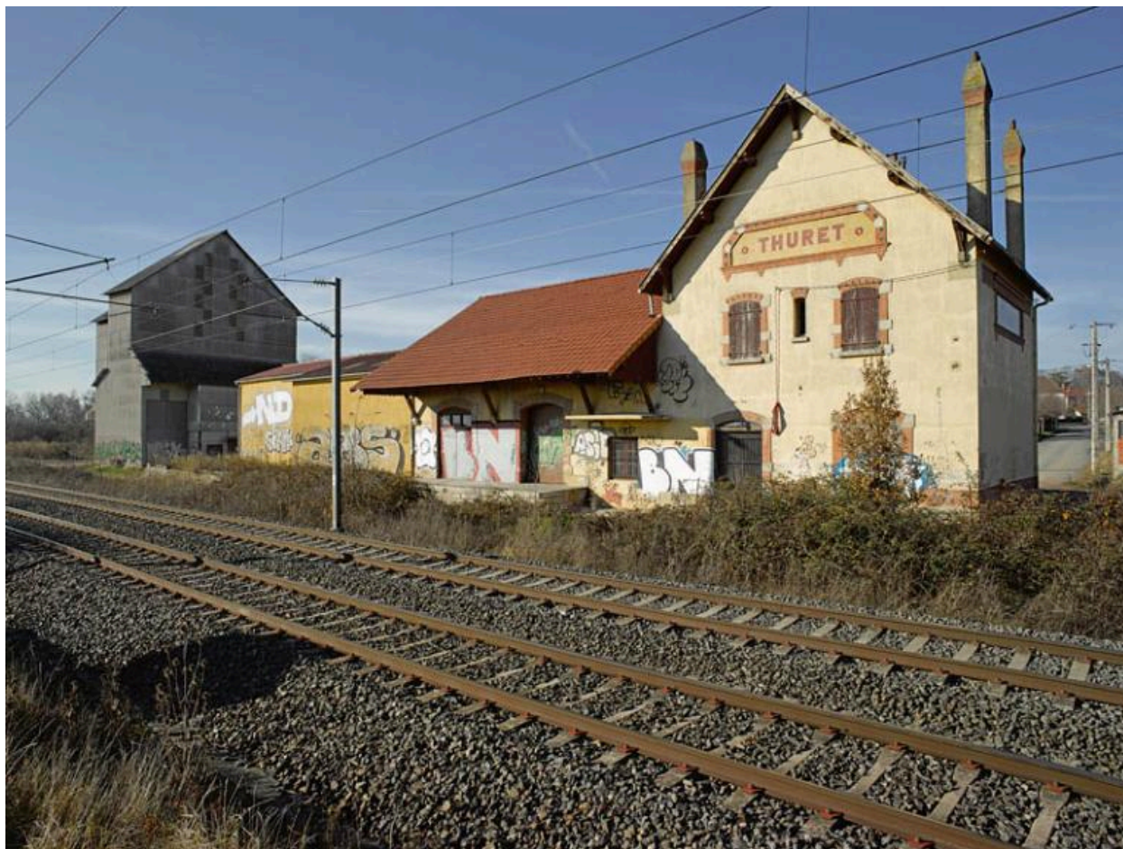
Gare désaffectée de Thuret.
