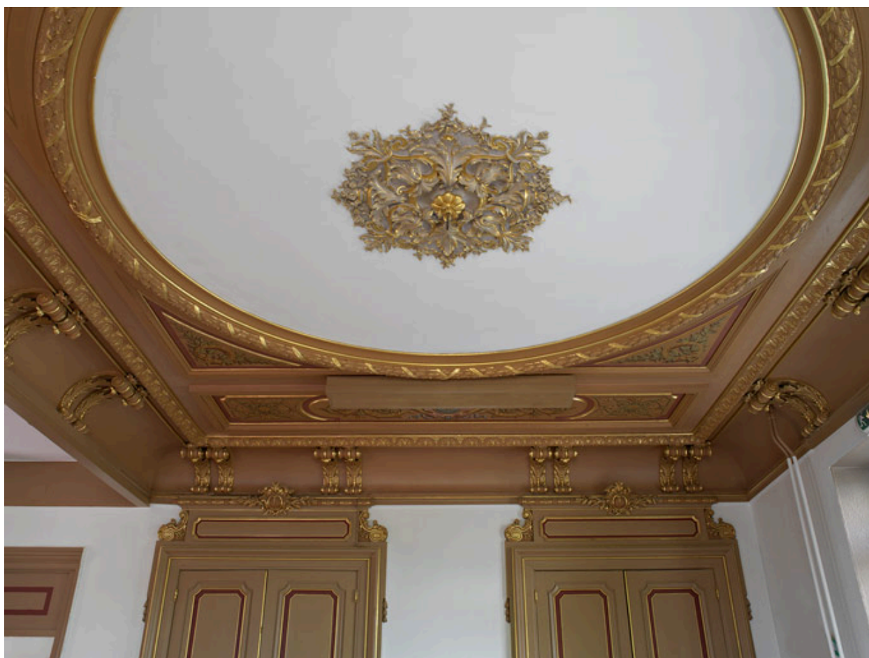
Vue partielle du plafond d'un salon.
