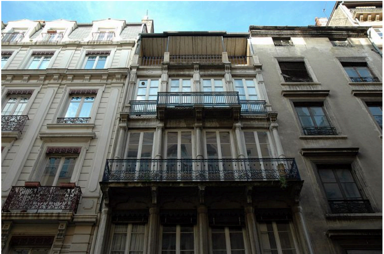
Elévation antérieure : partie supérieure
