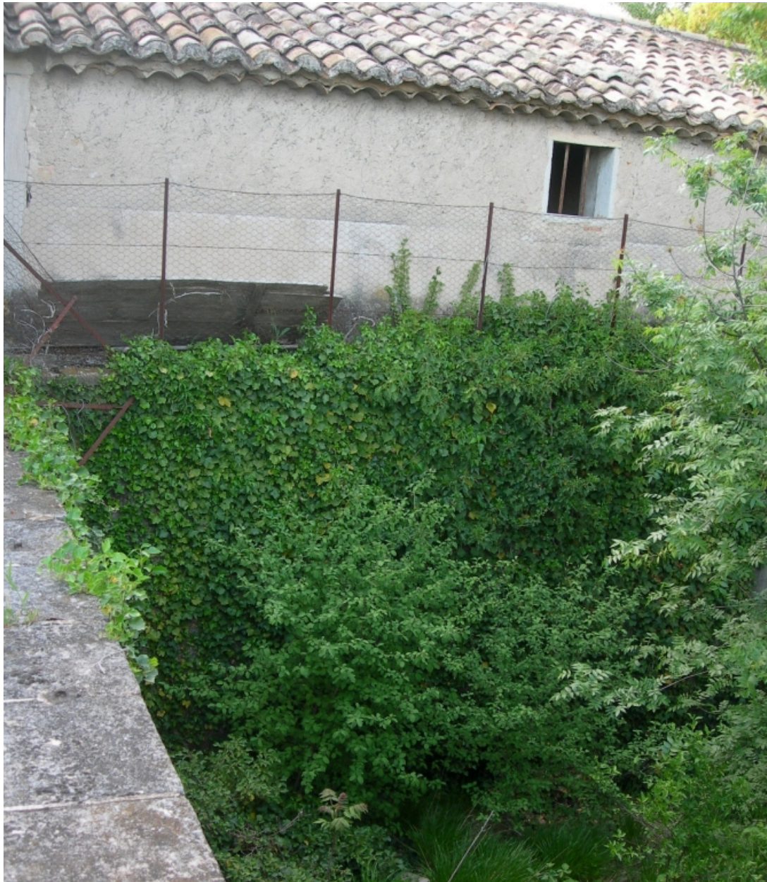
Bassin de retenue contre l'élévation postérieure (est), vue partielle.
