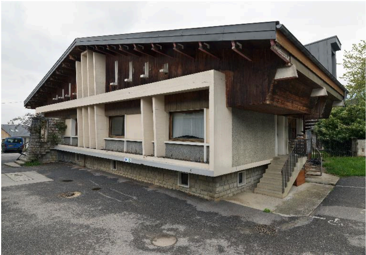
La Ribambelle (ITEP), Dessus Lavy, 2013 C3 207 à 209. Vue du bâtiment "le Chalet" (infirmerie, salle à manger, salles diverses) depuis le sud-ouest
