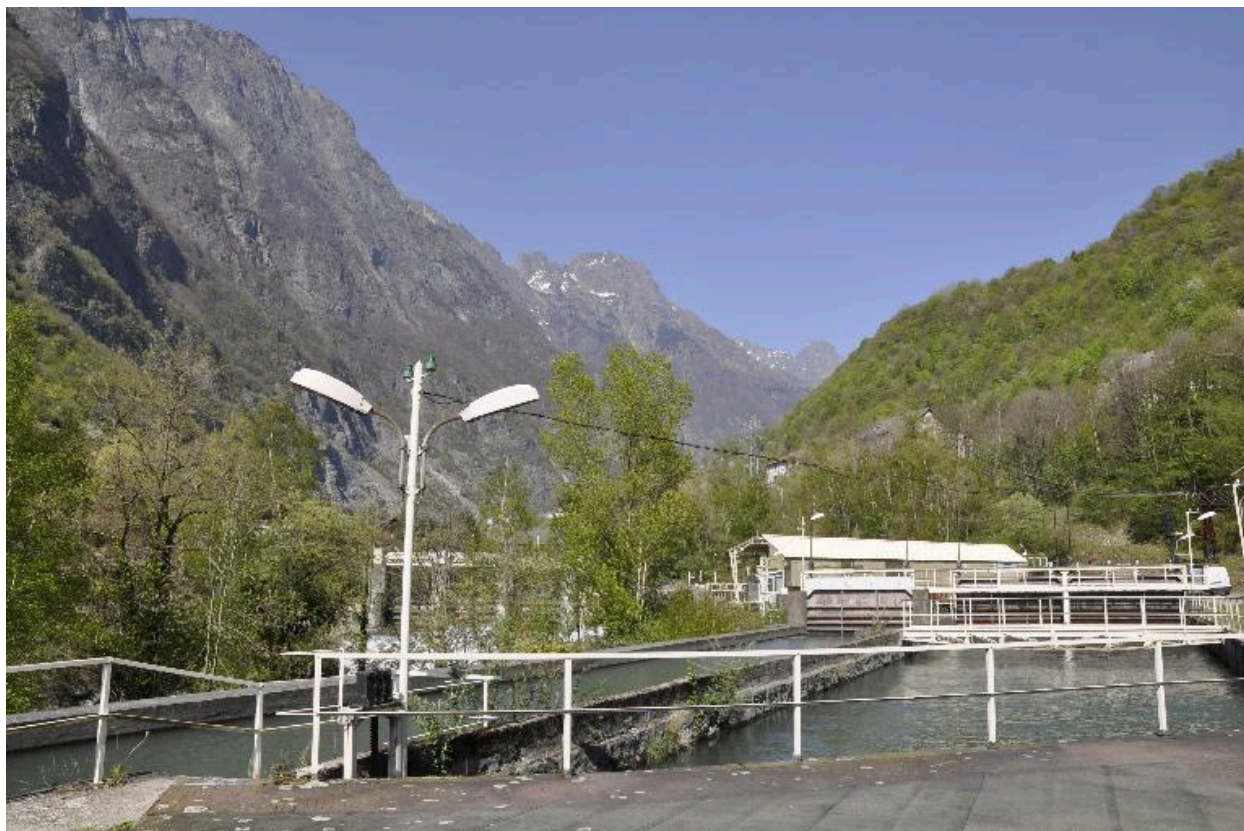
Vue de la chambre de mise en charge de la centrale
