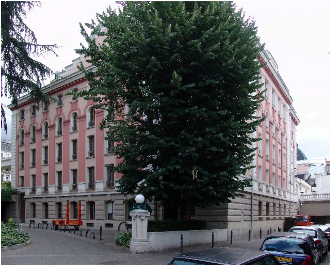
Vue prise du nord ouest
