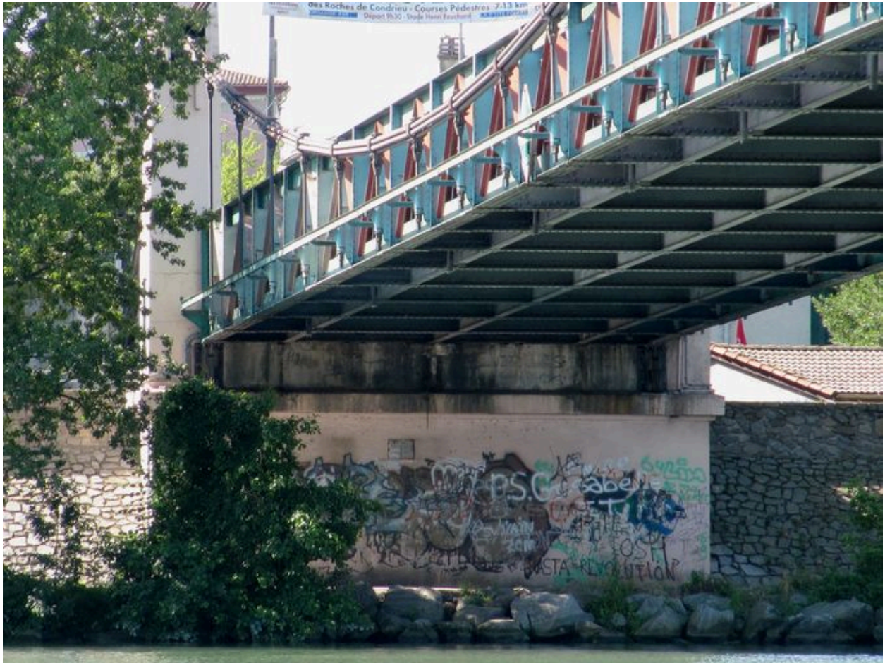
Culée de la rive gauche, face amont (depuis la rive droite)
