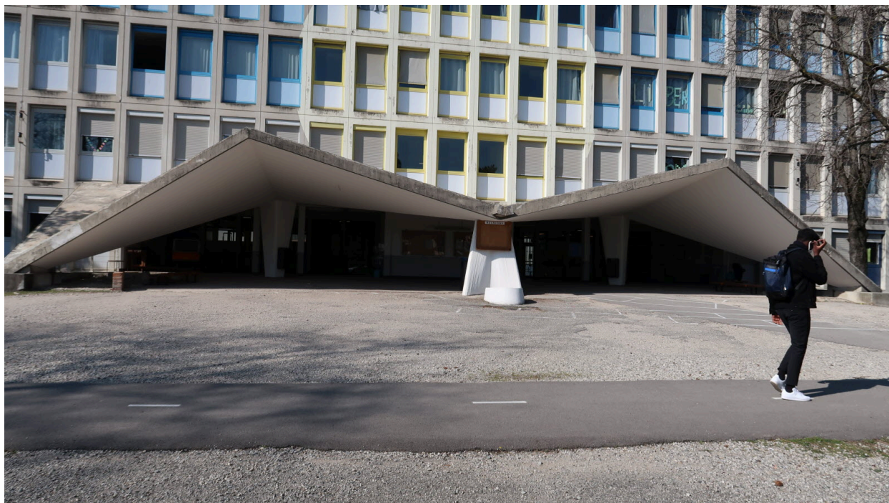
Vue partielle du bâtiment principal avant restructuration
