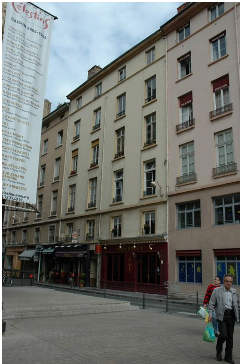
Lotissement concerté : 7 rue Charles-Dullin, façade
