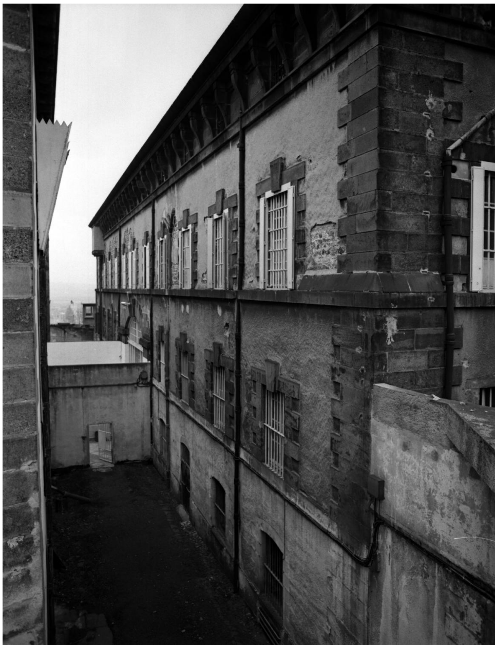
Depuis le chemin de ronde, au sud : élévation ouest du bâtiment de l'administration.
