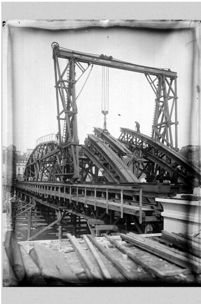
La construction du pont de la Boucle. La pose des poutrelles des arches supérieures. Photogr., [1903] (Arch. mun. Lyon. 15 Ph 1818)
