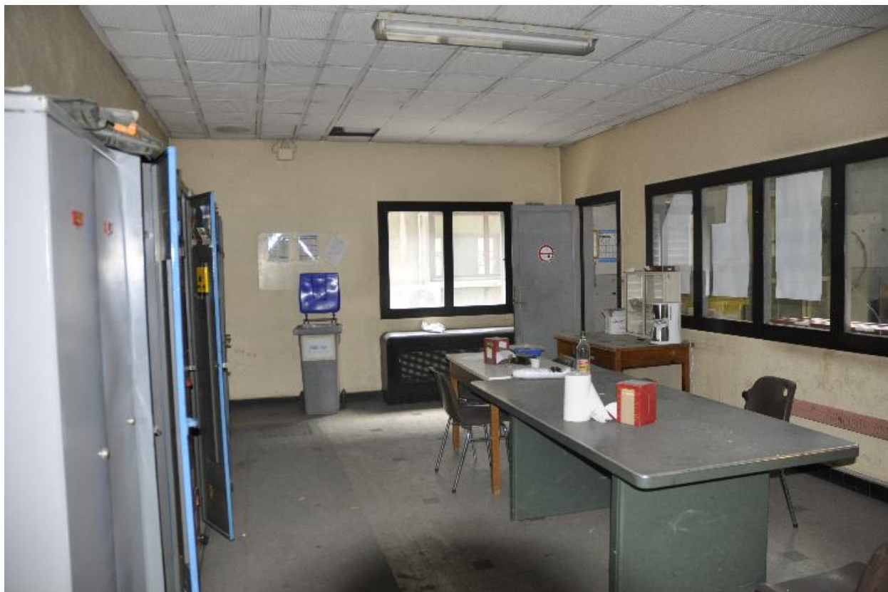
Vue de la salle de repos/vestiaires
