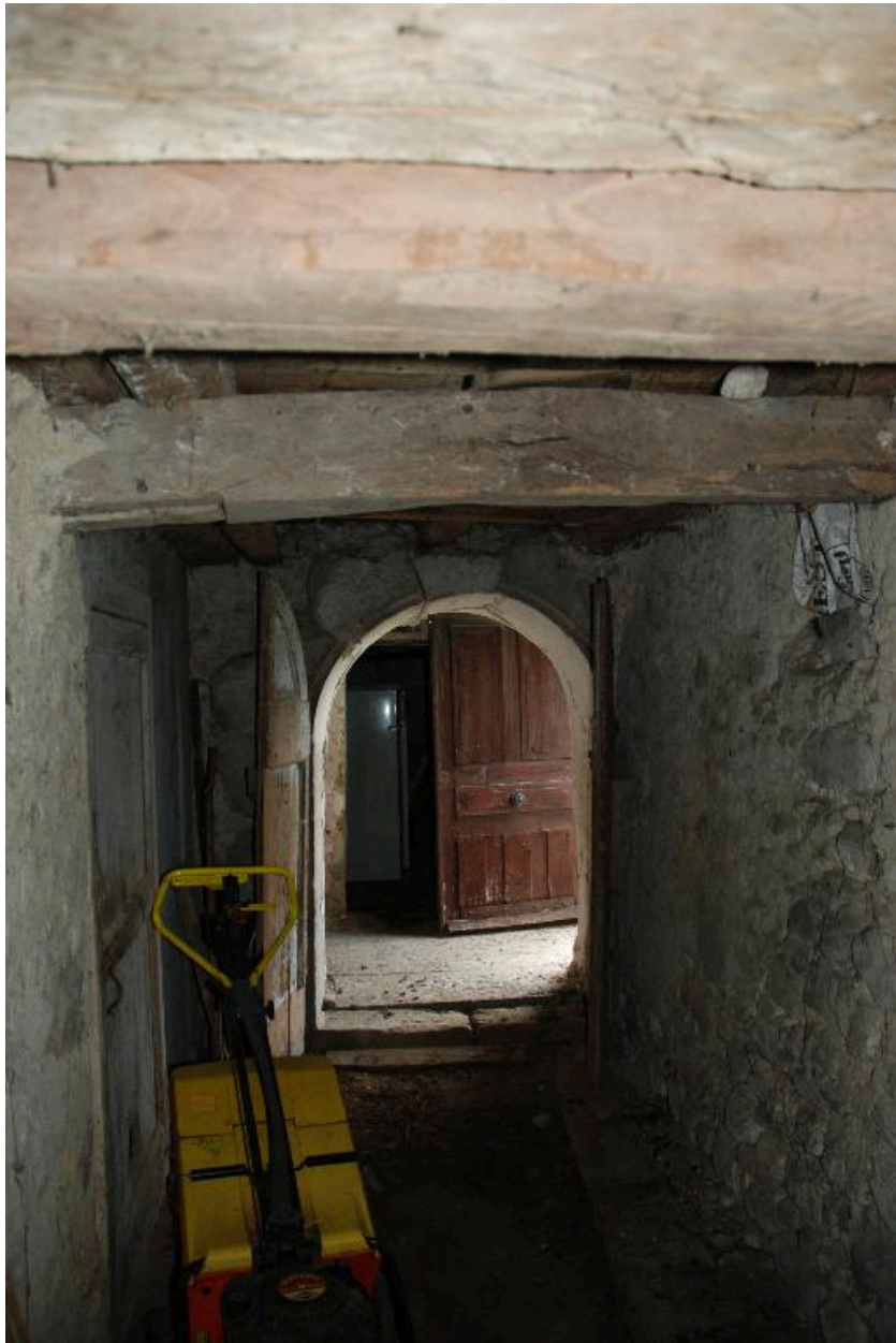
Vue du vestibule du rez-de-chaussée, vers l'escalier.
