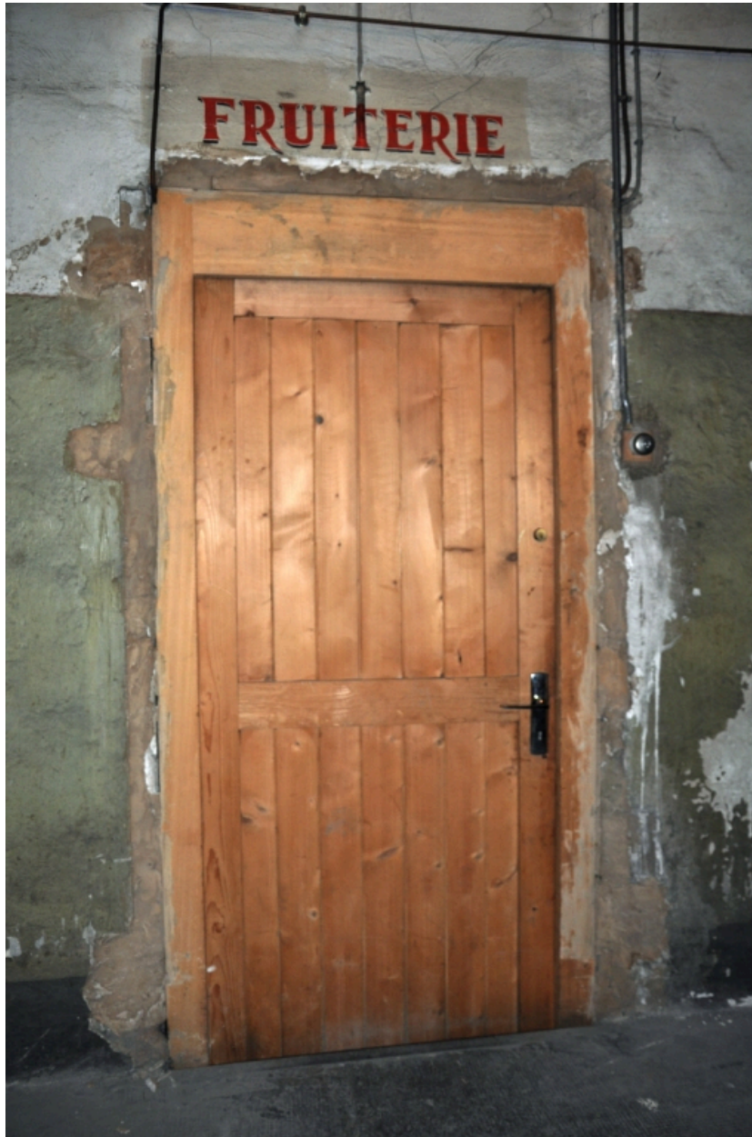
Sous-sol de l'aile N-W : ancienne porte de la fruiterie
