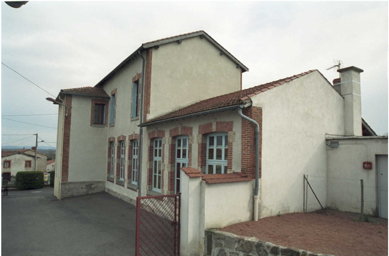
Vue d'ensemble des salles de classes, depuis le nord-ouest.
