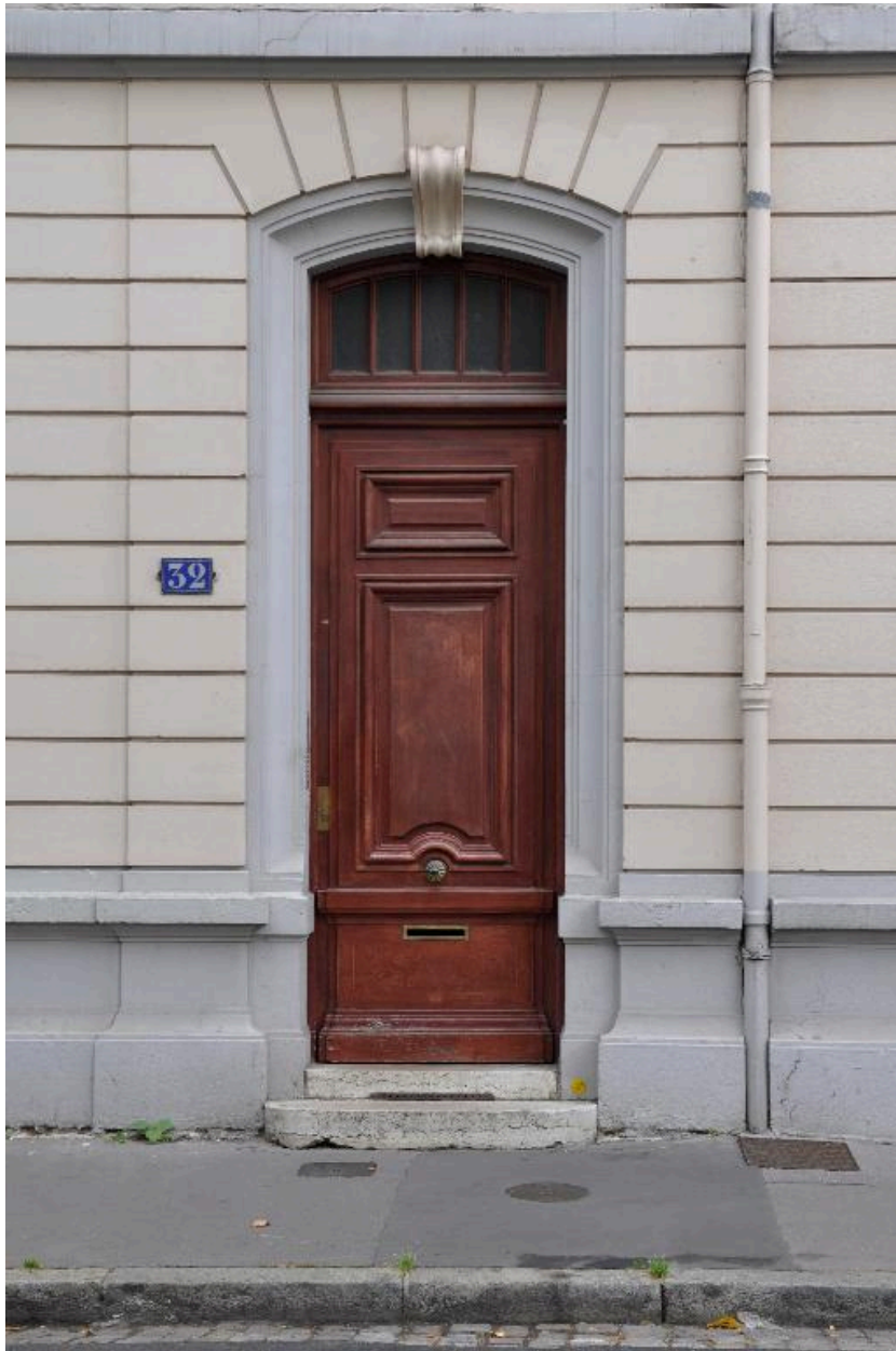
Elévation sur la rue du Père-Chevrier, détail de la porte piétonne
