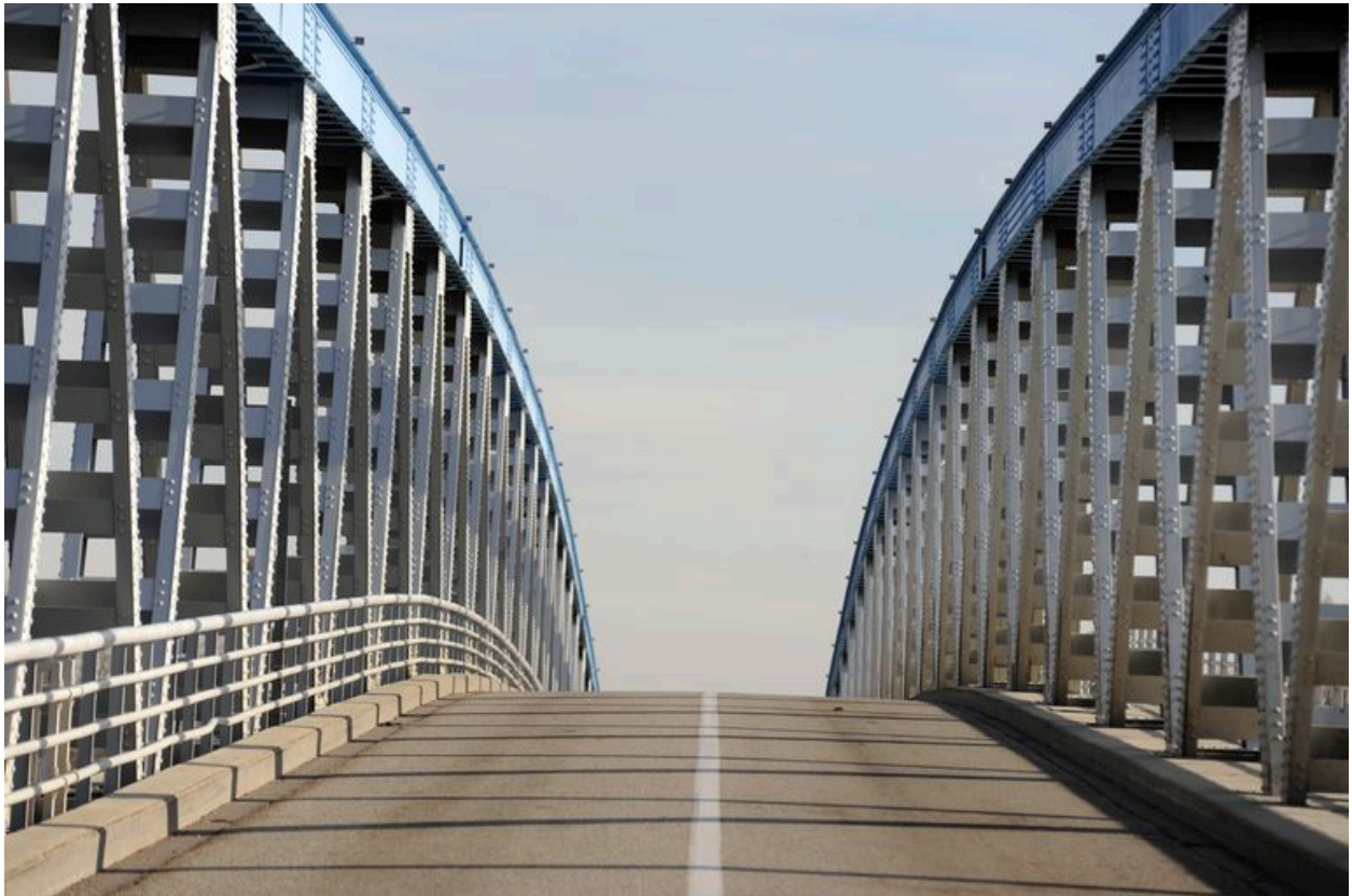
Vue partielle, de dessus, chaussée (depuis la rive droite)
