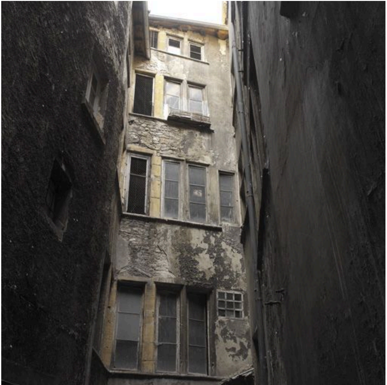
Bâtiment 4, vue des niveaux 2 à 5
