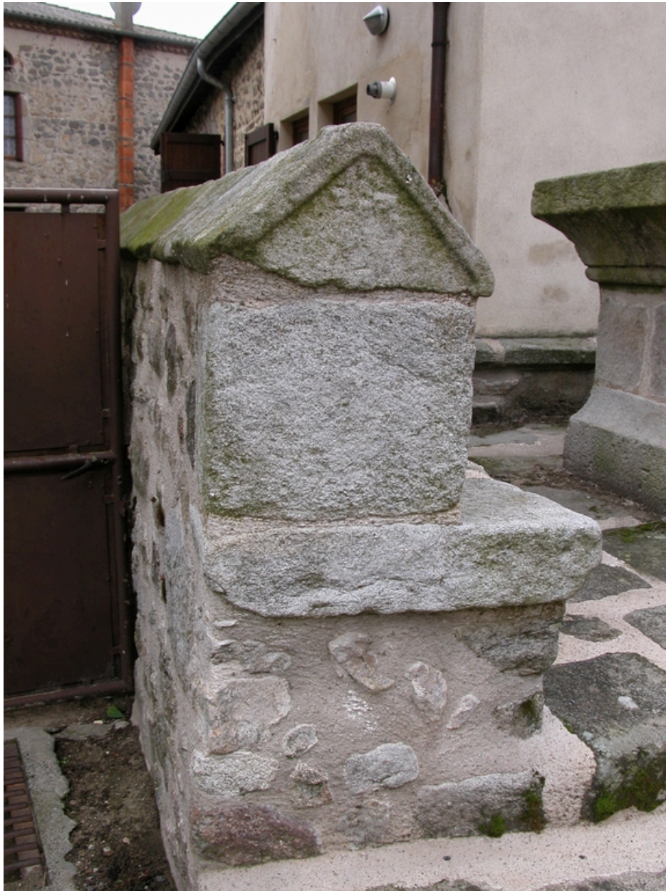
Détail de l'extrémité du muret, côté est.
