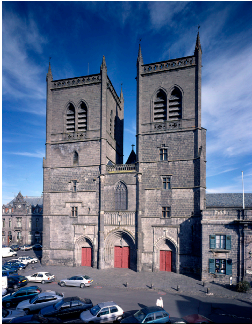
Vue de la façade occidentale
